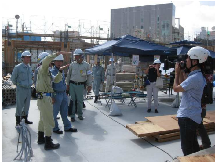
27年7月 那覇市内の建設現場を合同パトロール。
